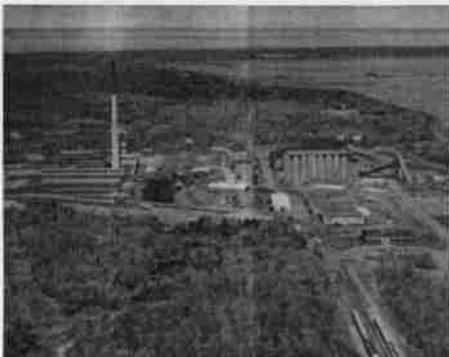
Abbildung 12: Kupferhütte und elektrolytische Raffinationsanlage der Copper Range Co. (links) sowie Erzbunker (rechts) direkt über dem *White-Pine-Bergwerk* in Michigan (USA). Im Hintergrund der Lake Superior. (Bild Metal Mining).
