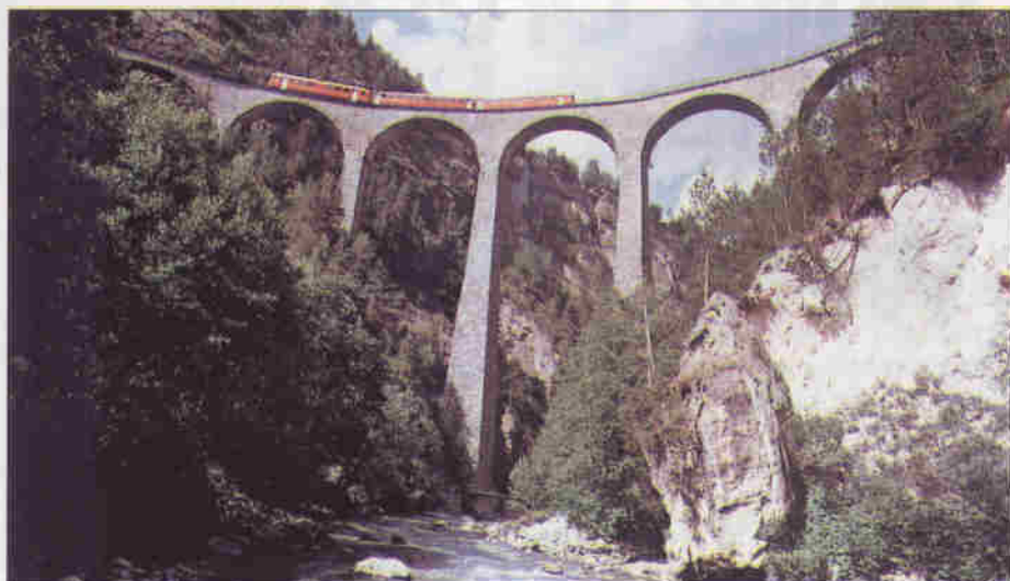
Der imposante Landwasserviadukt überquert das Tal in einer Kurve von 100 Meter Radius.
