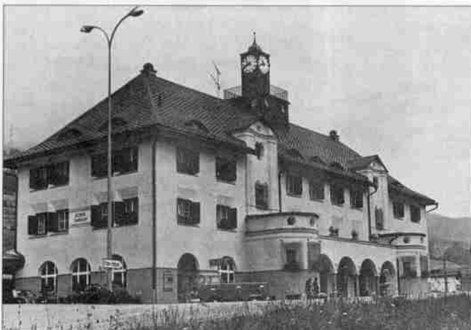
Das Stationsgebäude Scuol/Tarasp, ein Haus von fast festlichem Gepräge, das 1912/13 gebaut wurde.
