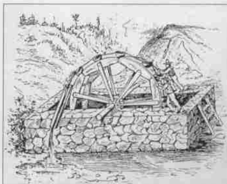
Alte mexikanische Minenpumpe, die noch per Hand betrieben wurde.
