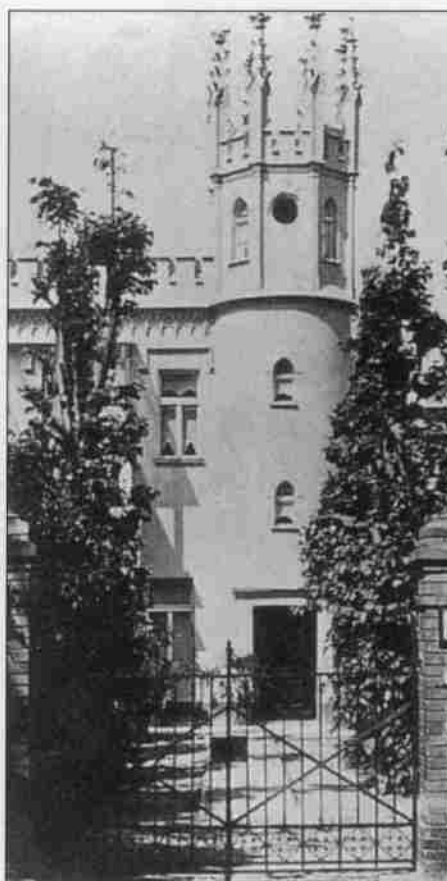
Eine 1873 gebaute Villa im neugotischen Stil in der Ulmenallee 3.
