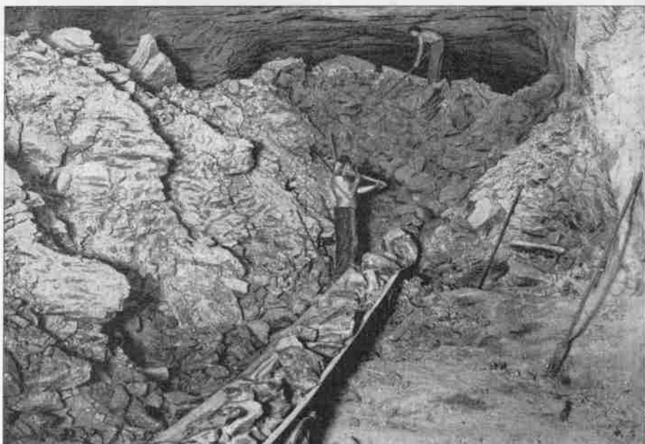
Schüttelrutschenbetrieb in einer Kalifirst 1000 m unter Tage auf Werk Volkenroda in Menteroda (Thür.).
