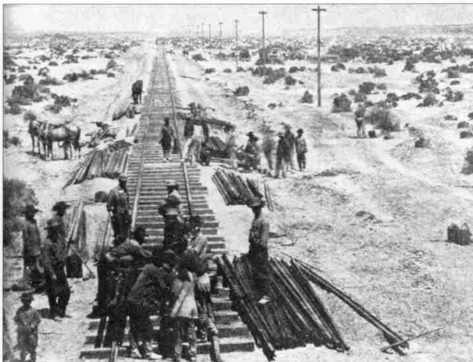
Schienenleger der Central Pacific auf dem Weg Richtung Osten durch Nevada.
