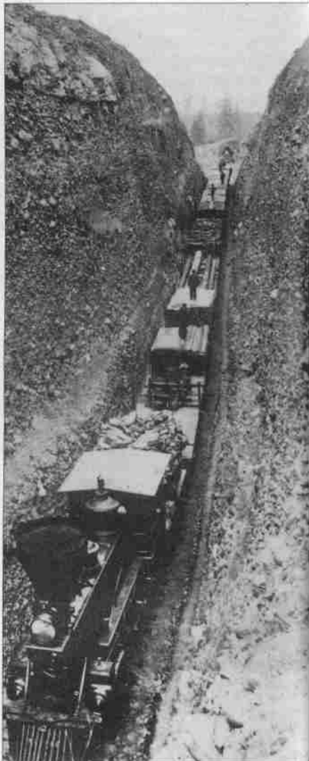
Beim Bloomer Cut in der Sierra schlug eine Kolonne der Central Pacific diesen 240 Meter langen Graben durch eine felsige Gesteinsformation.
