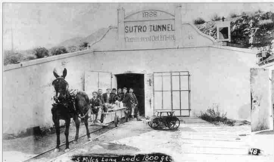
Abbildung 2: Eingang zum Sutro-Tunnel.
