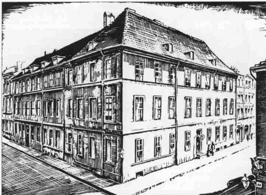
Das erste Domizil der Berlinischen Feuerversicherungs-AG in der Spandauer Str. 81, an der Ecke der neuen Friedrichstraße. Im ersten Stock befand sich das Geschäftslokal (Abb. Festschrift zum 150jährigen Jubiläum).
