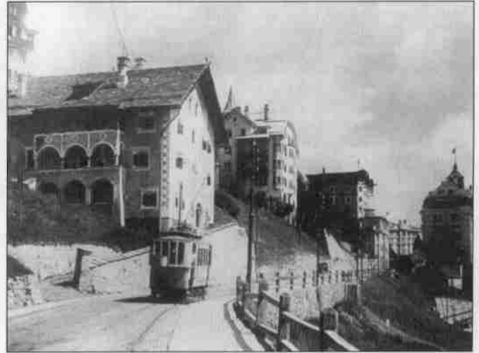
Die Strassenbahn fährt eben am Engadiner Museum vorbei. Gut sichtbar sind die Stützmauern, die zur nötigen Verbreiterung der Straße gebaut werden mußten.
