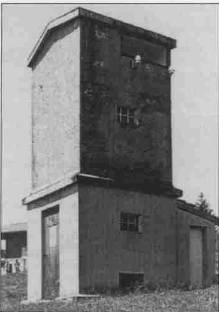
Alte Trafostation „Rigi-First“.
