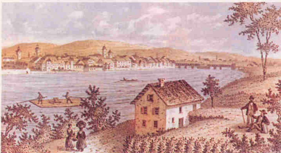
Biedermeieridylle mit Blick über das Höllhakenhaus auf das Schweizer Rheinfelden mit der alten Holzbrücke (Stich um 1850).
