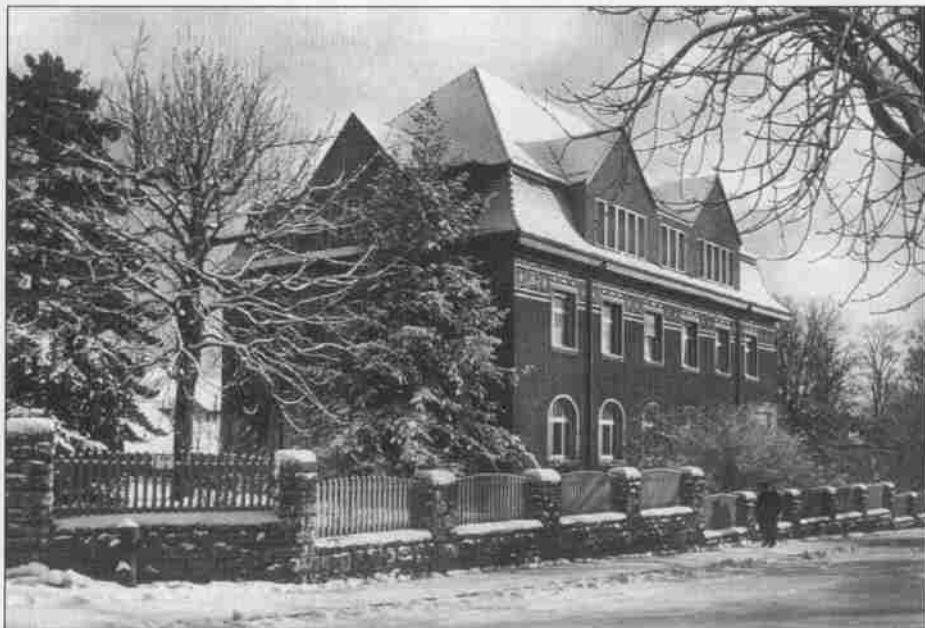
Das Verwaltungsgebäude der Kraftübertragungswerke Rheinfelden auf der badischen Seite, erbaut Sommer 1908 bis Sommer 1909.
